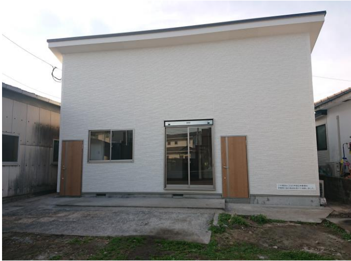
改修後の施設正面
