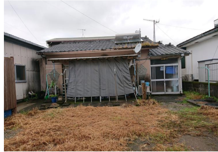
改修前の施設正面
